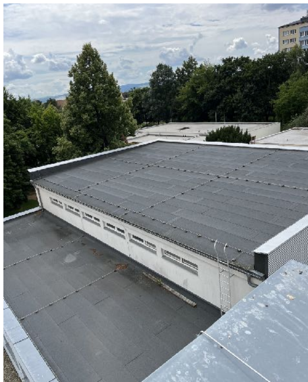
Obrázek 4 - Střešní konstrukce s SBS pásem
