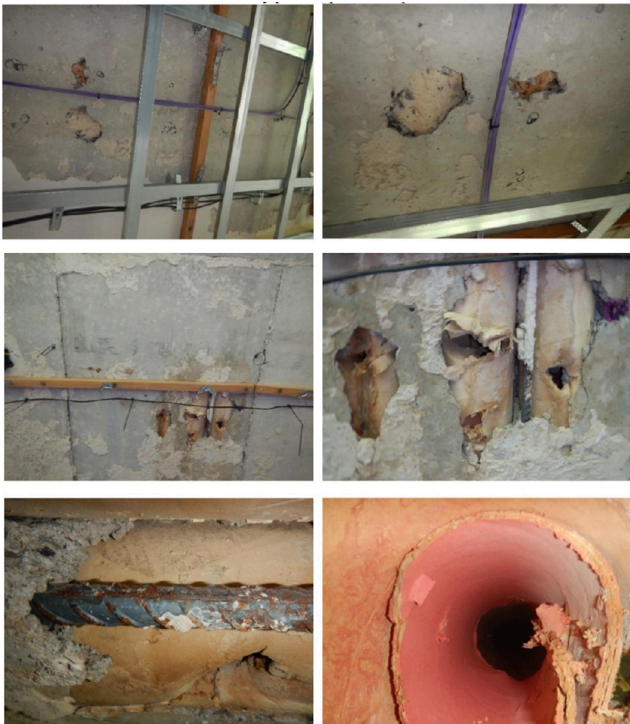
Obrázek 5 Stav stropních panelů nosné konstrukce střechy
